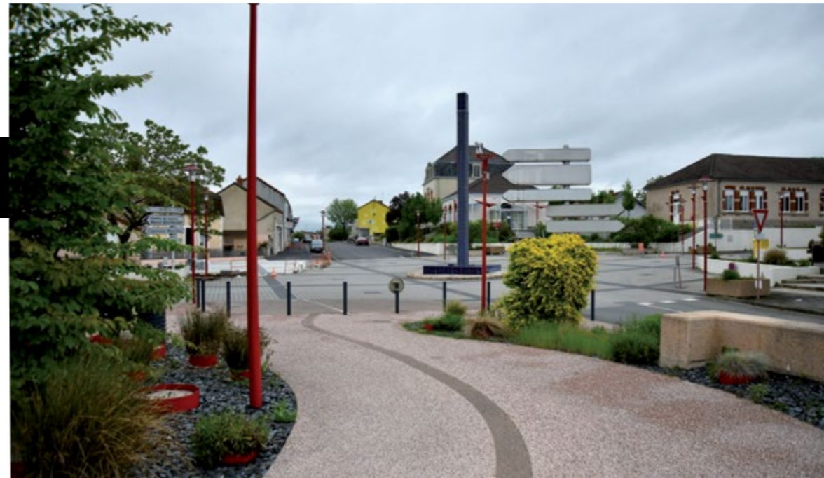
Réalisé par la communauté urbaine, en partenariat avec la commune, le centre-ville de Saint-Vallier a fait l'objet de transformations et d'une revalorisation urbaine.
